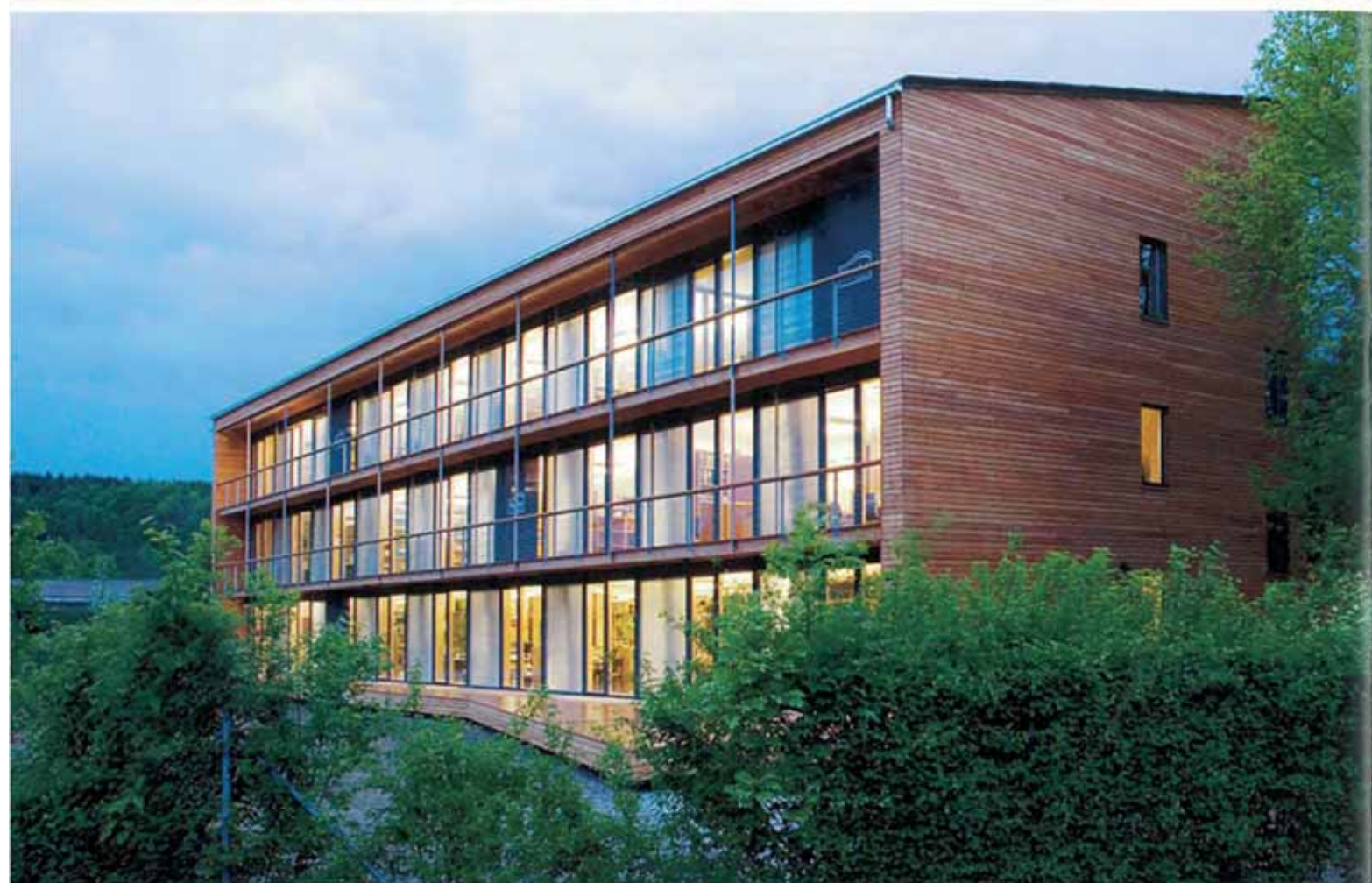
Südfassade mit GlassX-Elementen.
