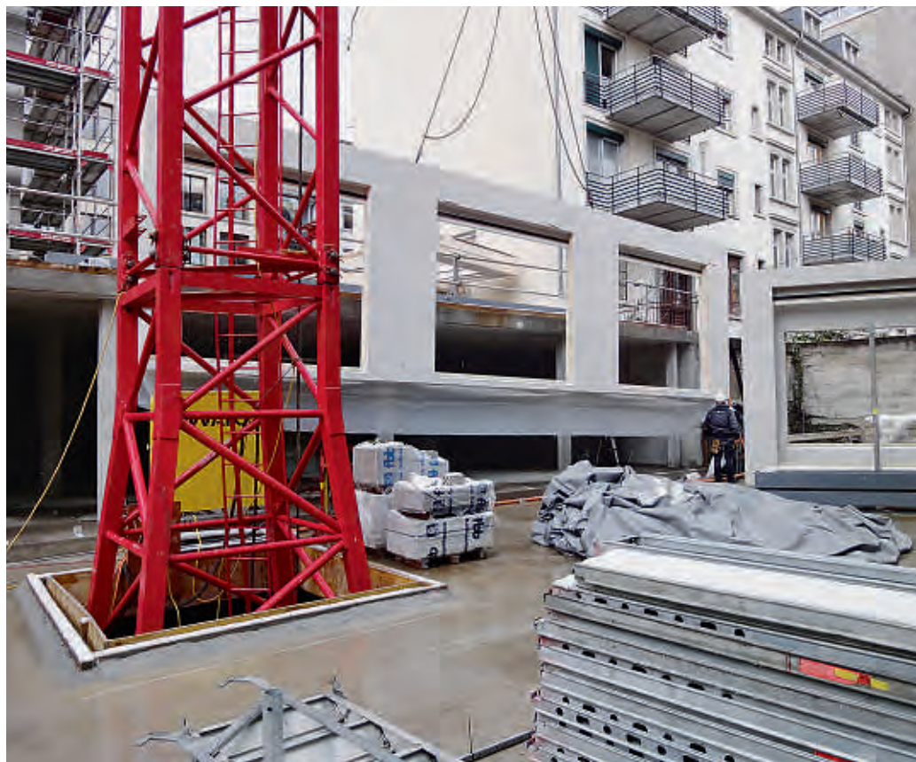
Beide Gebäude sind in vorfabrizierter Holzbauweise erstellt und weisen spezielle Holz-Beton-Verbunddecken auf.
