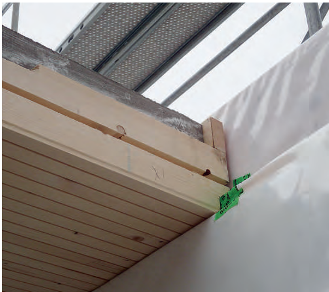
Beide Gebäude sind in vorfabrizierter Holzbauweise erstellt und weisen spezielle Holz-Beton-Verbunddecken auf.
