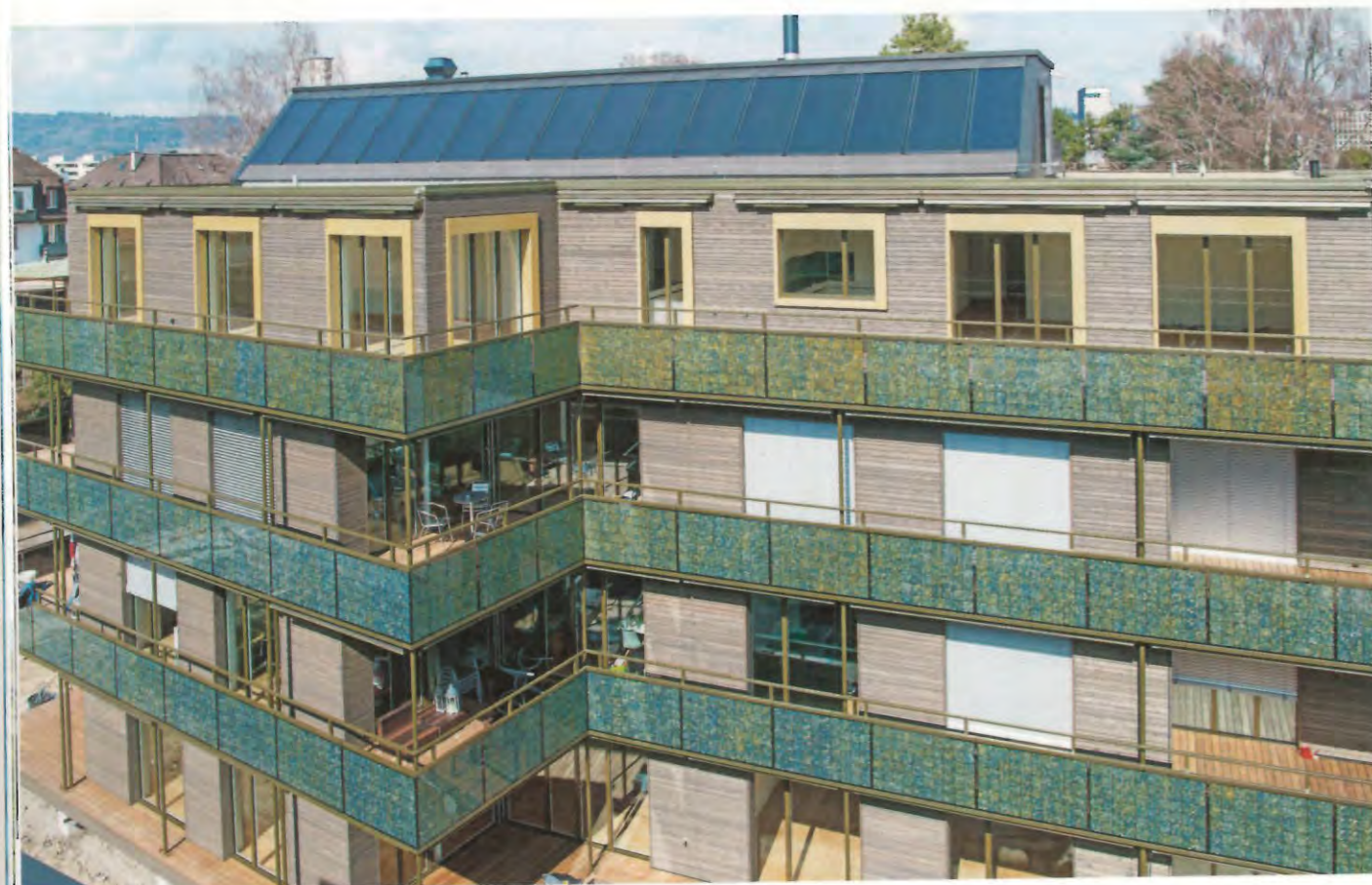
Gut kaschiert – Photovoltaikmodule an den Brüstungen und Sonnenkollektoren auf der abgeschrägten Dachzentrale mit dem zentralen Lüftungsgerät.
