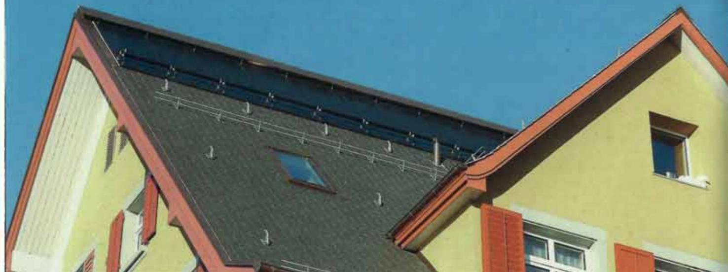
Die 75 m<sup>2</sup> Sonnenkollektoren liefern Wärme für Heizung und Warmwasser. Und im Sommer werden mit den solaren Wärmeüberschüssen die Erdsonden regeneriert.
