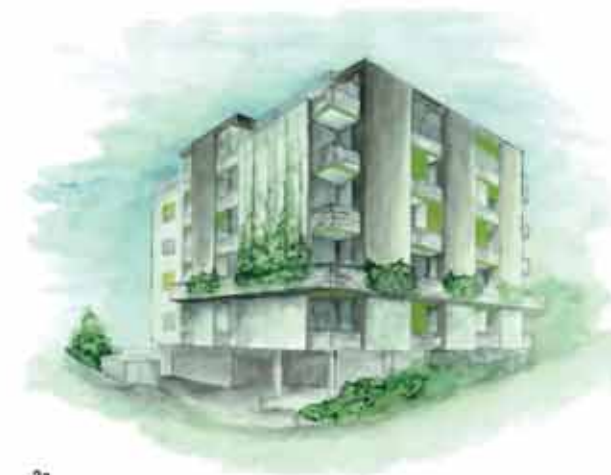
2a | 2b Stettbachstrasse 43 in Zürich-Schwamendingen – ein Umbauprojekt eines Mehrfamilienhauses aus den 1970er-Jahren: Photovoltaik auf dem Dach und Sonnenkollektoren an den Fassaden, die nicht Strom, sondern Wärme für Warmwasser und Heizung produzieren.
