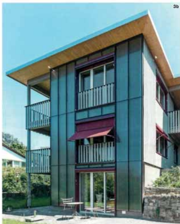
3a | 3b Das Haus «Eichhalde» in Zürich-Witikon vor und nach der Sanierung. Dank farblich passender, grauer Solargläser fügen sich die Sonnenkollektoren an der Fassade optimal ins Erscheinungsbild des Gebäudes ein. Quelle: Ernst Schweizer Metallbau AG, Reinhard Zimmermann, Baar
